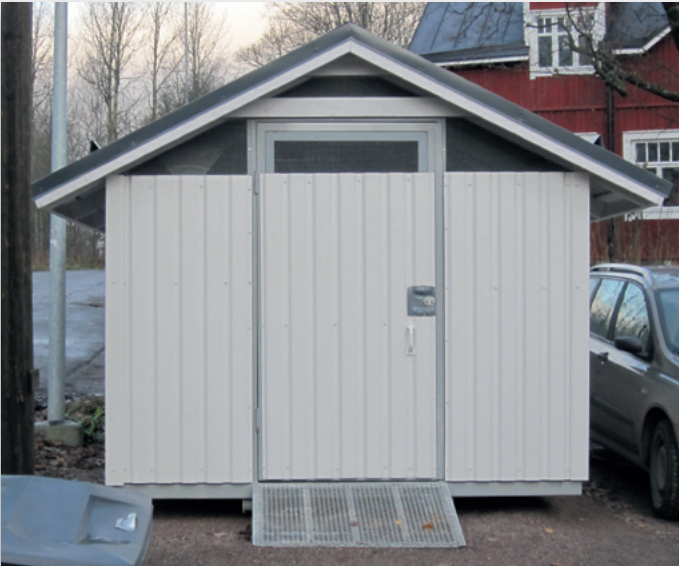
Yläosien verkotus ja ovien lukitus suojaavat eläimiltä ja ilkivallalta
