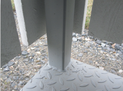
Tukevasti lattiaan hitsatut neliöprofiilitolpat.
