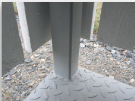
Tukevasti lattiaan hitsatut neliöprofiilitolpat.
