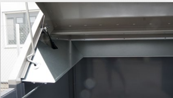
Sisäosassa ohjaimet, joiden avulla roskat menevät aina säiliöön
