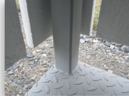
Tukevasti lattiaan hitsatut neliöprofiilitolpat.
