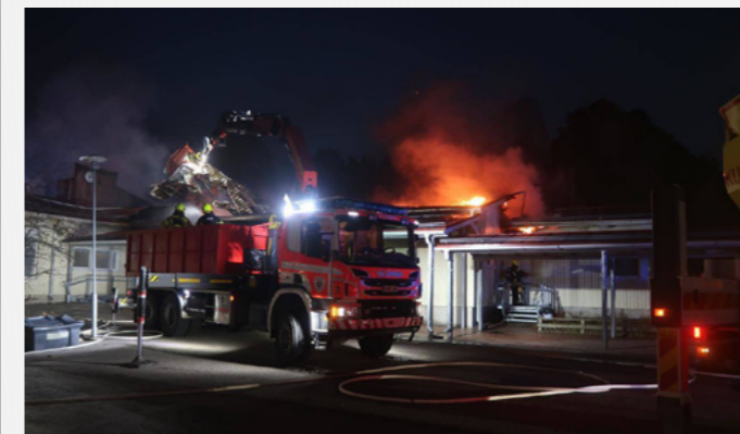
Lepsämän koulun tuhopoltto. (Kuva: Keski-Uudenmaan Pelastuslaitos)
