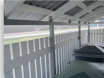
Rungon ja katon kiinnitys on tehty kestäväksi vuosikymmeniä.
