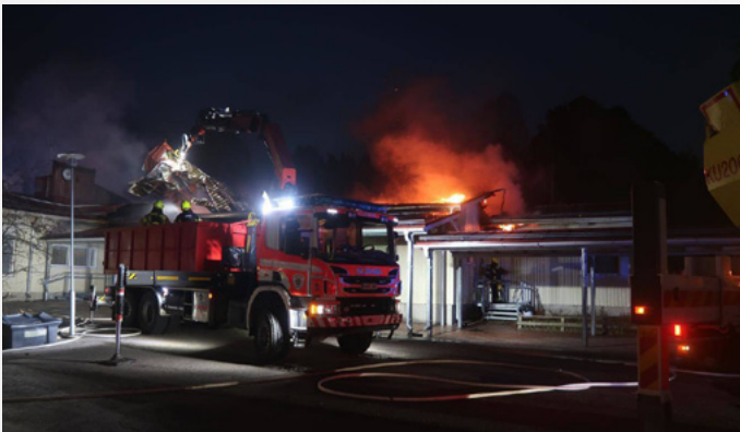
Lepsämän koulun tuhopoltto. (Kuva: Keski-Uudenmaan Pelastuslaitos)
